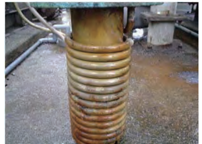
ほとんど錆が無くなった。
